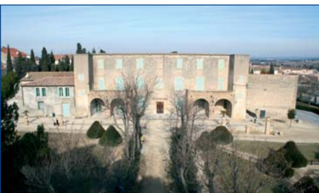
Les travaux se poursuivent.
