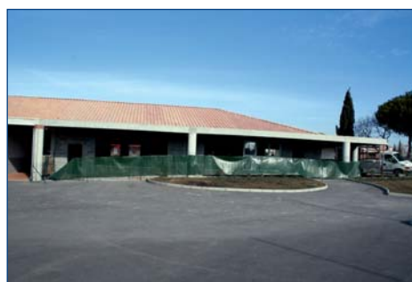
La seconde tranche du groupe scolaire Jules Verne déjà bien avancée.
