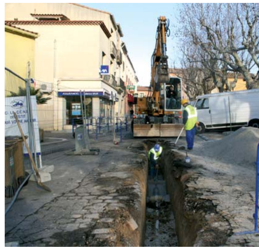
Changement des conduites d'eau rue Garibaldi.
