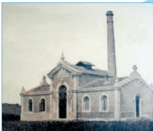
L'ancienne usine de pompage à vapeur au Sesquier qui abrite aujourd'hui le centre de loisirs.
