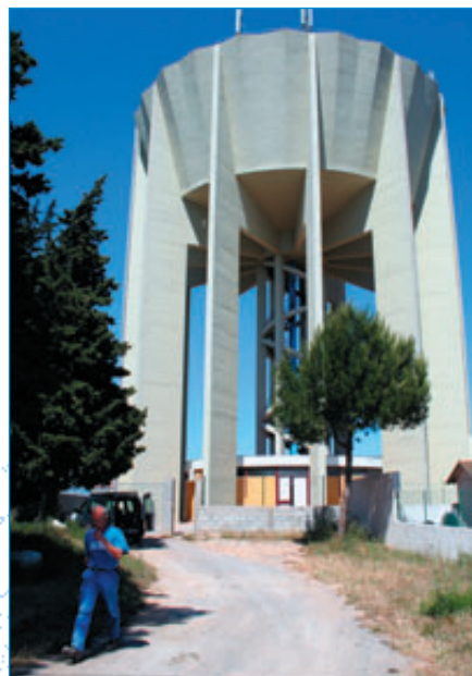
Le château d'eau des Lions construit en 1962 : un réservoir de 2000 m 3 .
