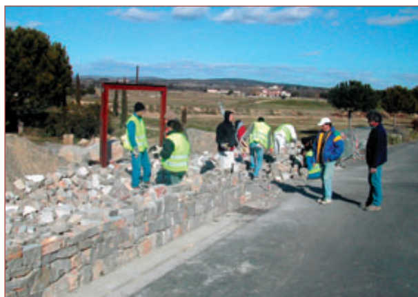
Le chantier d'insertion du Sesquier.
