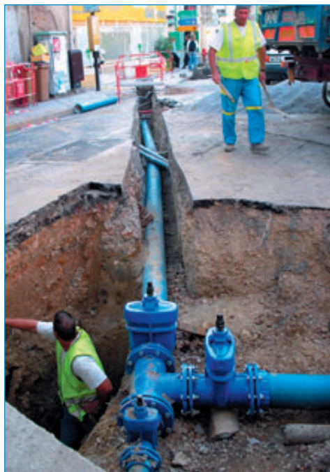
Remplacement des conduites d'eau potable.
