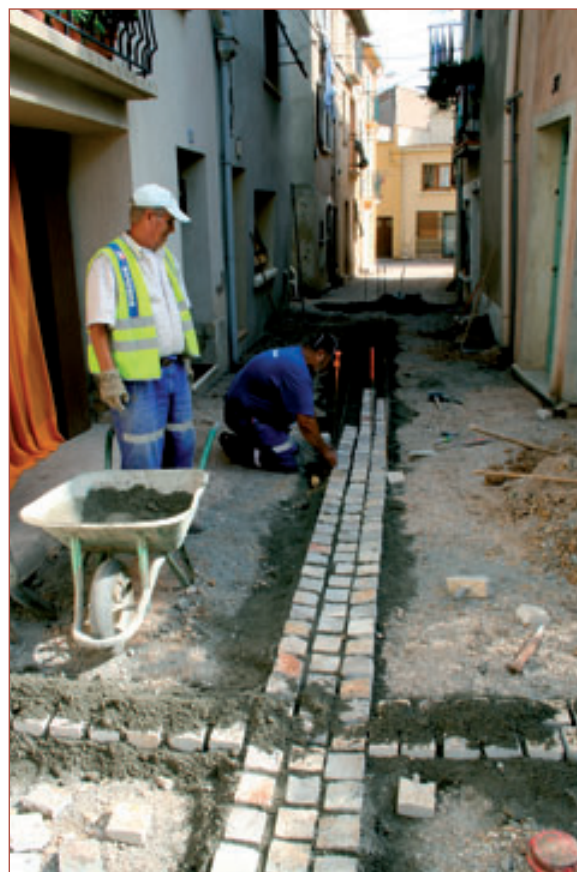
Réfection de la chaussée rue du Barreau.
