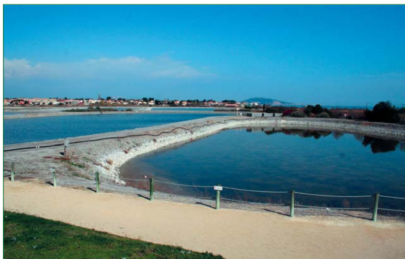
La station de lagunage de Mèze.
