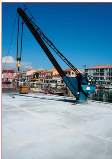
Réfection de la zone carénage...
