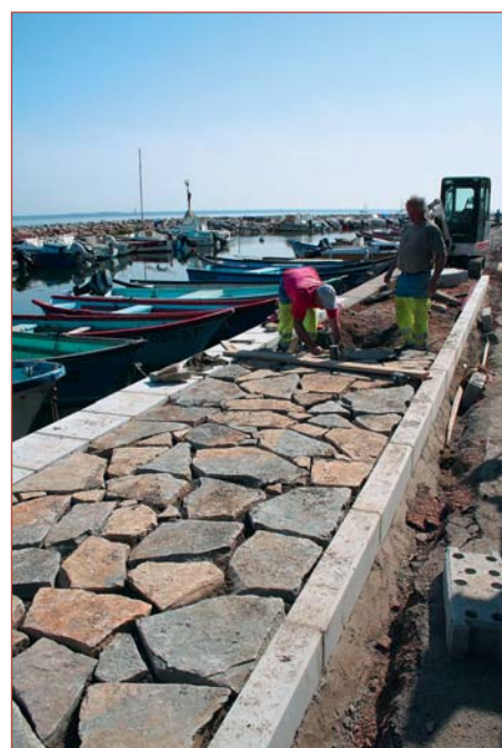
Réalisation de la promenade chemin de l'Étang.
