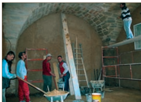
Restauration d'une salle voûtée de la Cavalerie.
