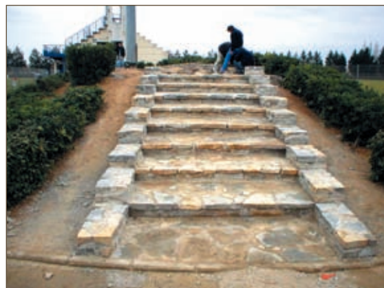
Réalisation d'un escalier de pierre par les futurs diplômés du CAPA.
