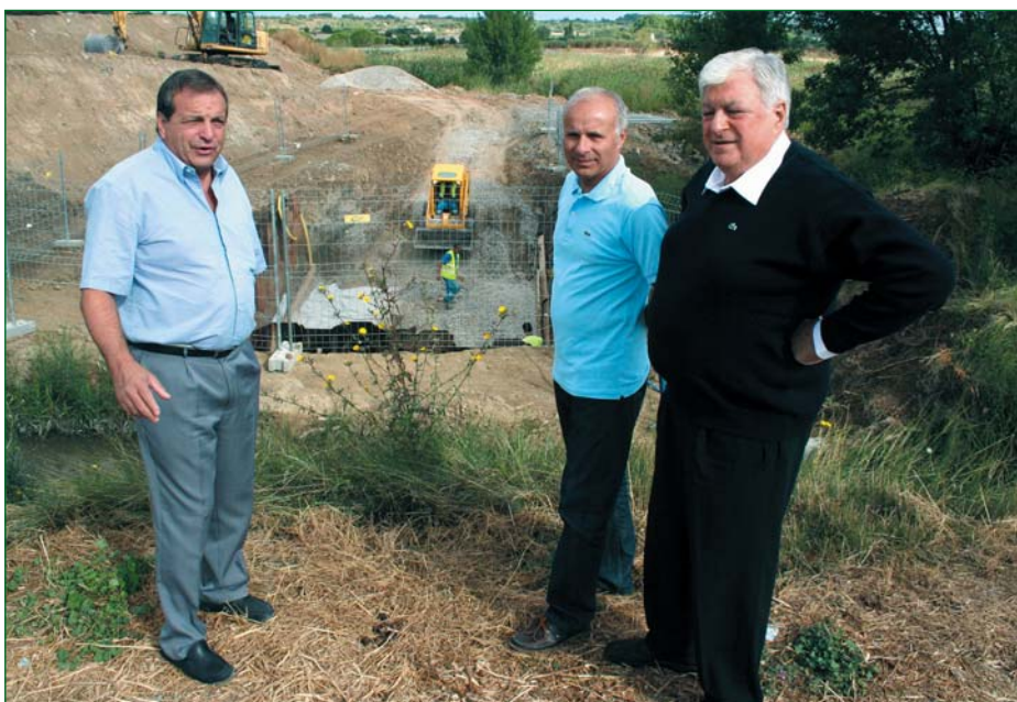
Travaux d'installation des pompes au Sesquier.
