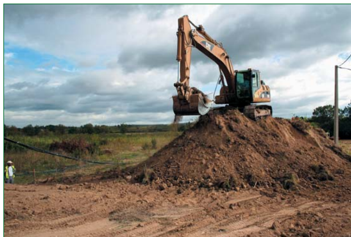
Travaux de terrassement sur le tracé de l'ancienne voie ferrée.
