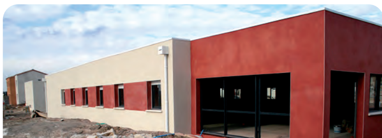
Avancement des travaux de la nouvelle gendarmerie.
