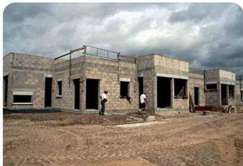
La future crèche de Mèze en cours de réalisation
