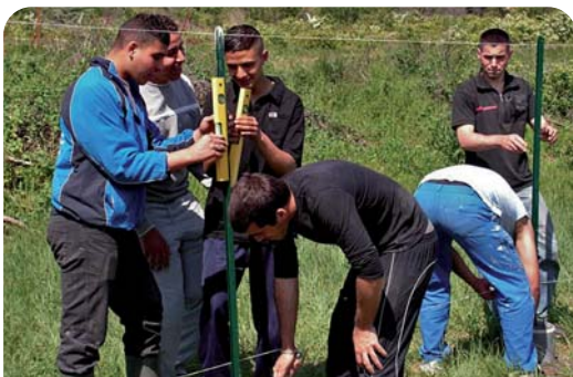
Le chantier d'insertion sur les jardins familiaux de la Ville
