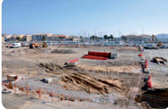
L'aménagement de l'aire des festivités : un chantier de 12 000 m 2
