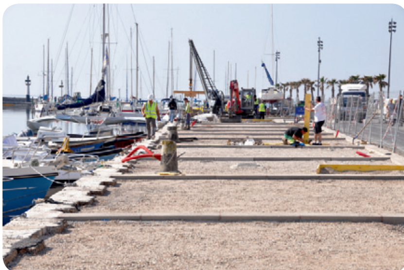
La promenade autour du port en cours de réalisation.
