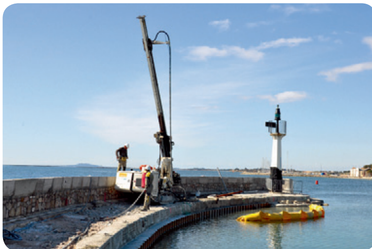
Travaux de renforcement de la jetée du quai Guitard.
