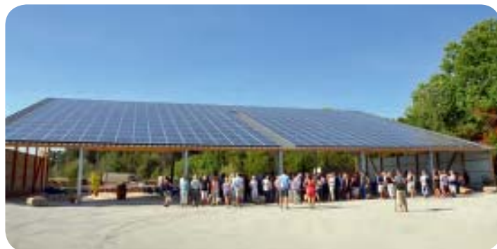
La structure permettra d'organiser des manifestations festives à l'abri du soleil et des intempéries durant la saison estivale.
