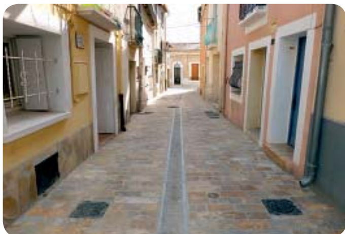
Pose de pavés de pierre rue Raspail...
