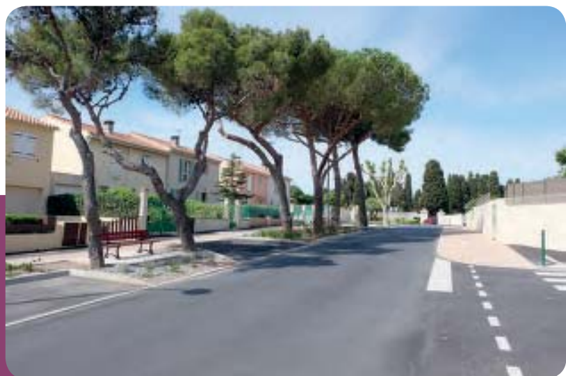
La rue des Adieux entièrement réaménagée
