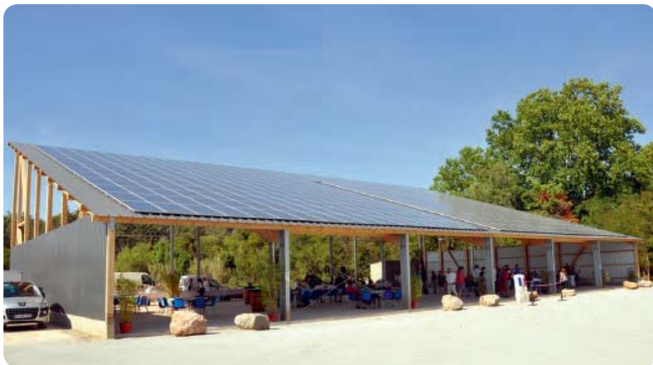
La halle du Sesquier, un espace de 800 m 2 couvert de panneaux photovoltaïques.
