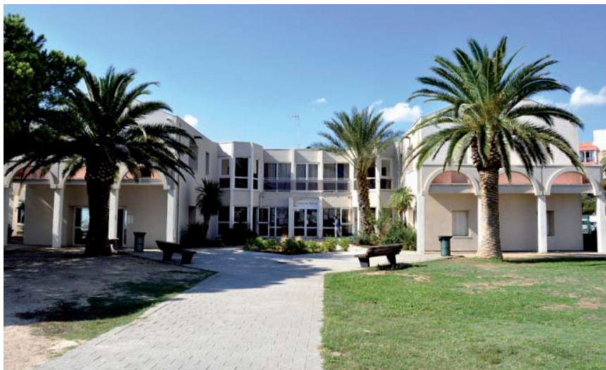
Poursuite de la rénovation du Taurus sur le centre d'hébergement et le cinéma municipal.
