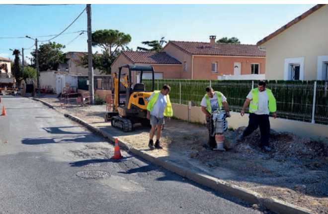
Réfection des réseaux sous terrains route de Villeveyrac.
