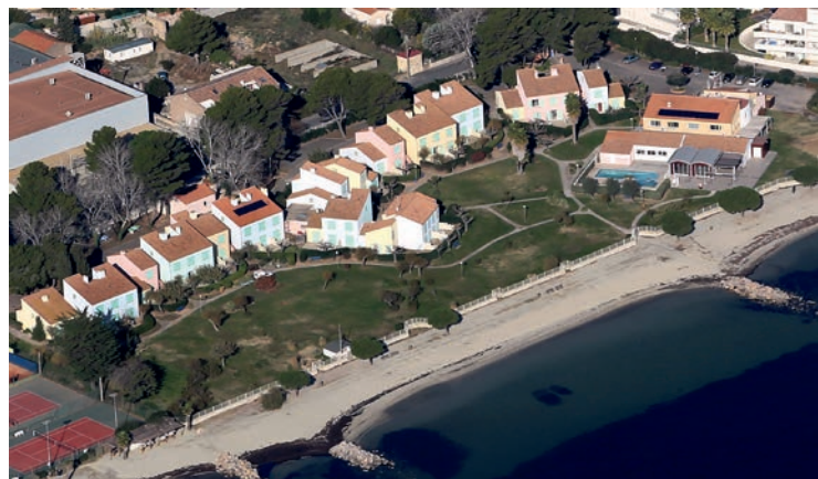
Rénovation de 1 700 m 2 de toitures au Thalassa.
