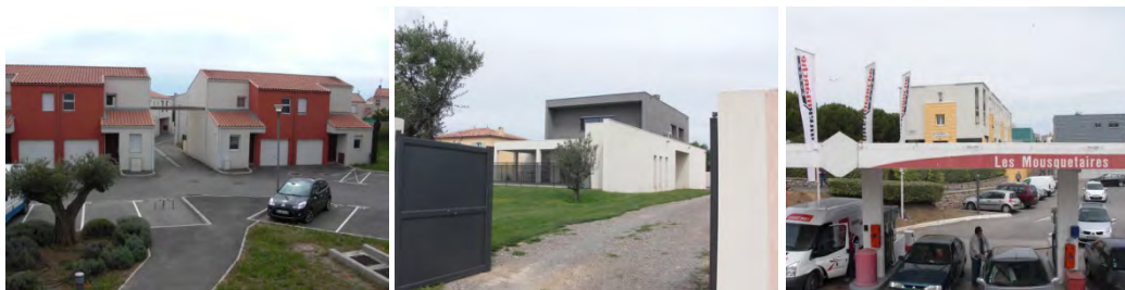
Vues sur des espaces / éléments architecturaux représentatifs.
