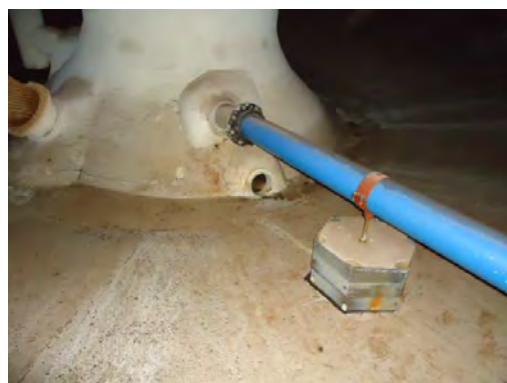
Vidange et tuyau d'évacuation des eaux pluviales
