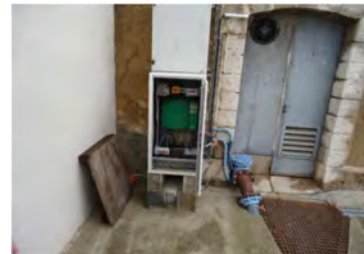
Porte d'accès aux cuves
