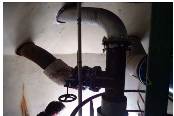
Vidange, trop plein et évacuation des eaux pluviales
