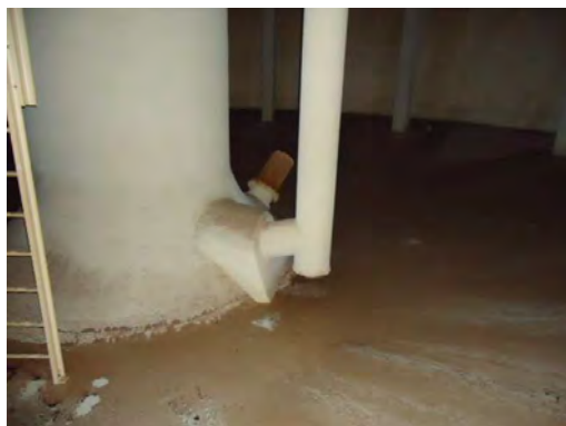
Intérieur de la cuve
