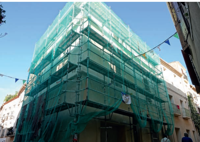
116 000 € ont déjà été consacrés à l'aide à la rénovation de 29 façades.
