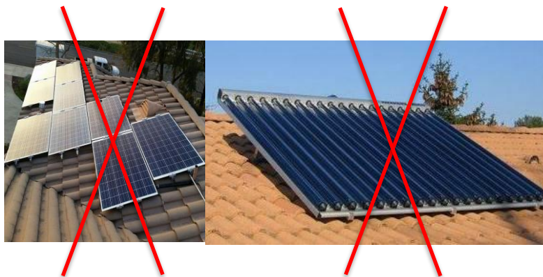
Implantations interdites : implantations anarchiques et/ou en surinclinaison
