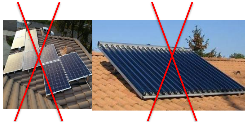
Implantations interdites : implantations anarchiques et/ou en surinclinaison
