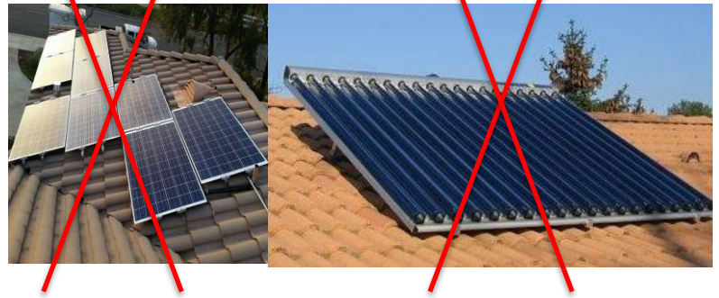
Implantations interdites : implantations anarchiques et/ou en surinclinaison
