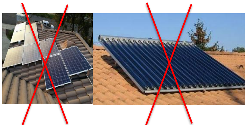
Implantations interdites : implantations anarchiques et/ou en surinclinaison
