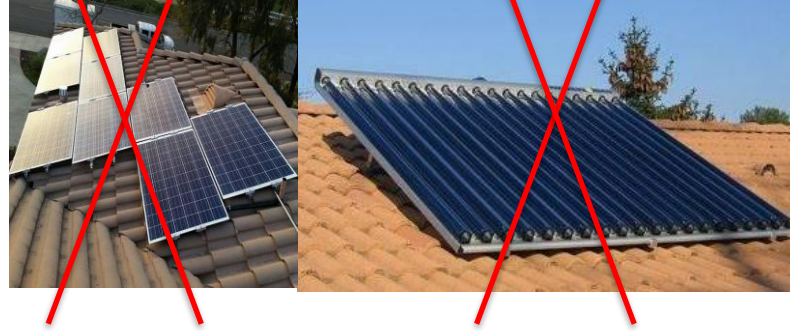
Implantations interdites : implantations anarchiques et/ou en surinclinaison
