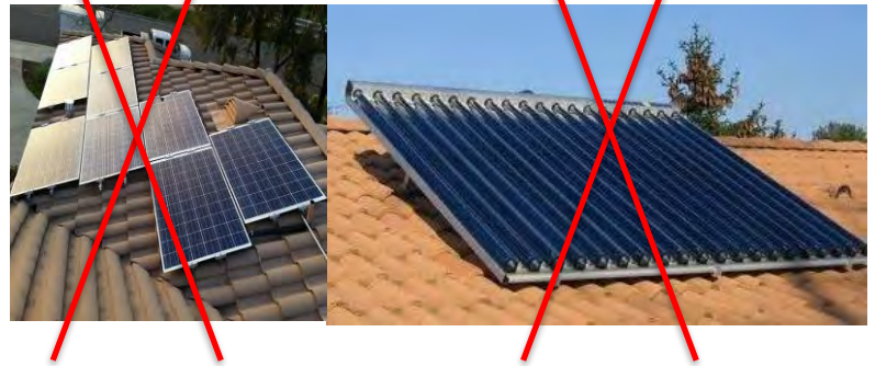
Implantations interdites : implantations anarchiques et/ou en surinclinaison
