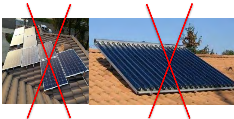
Implantations interdites : implantations anarchiques et/ou en surinclinaison
