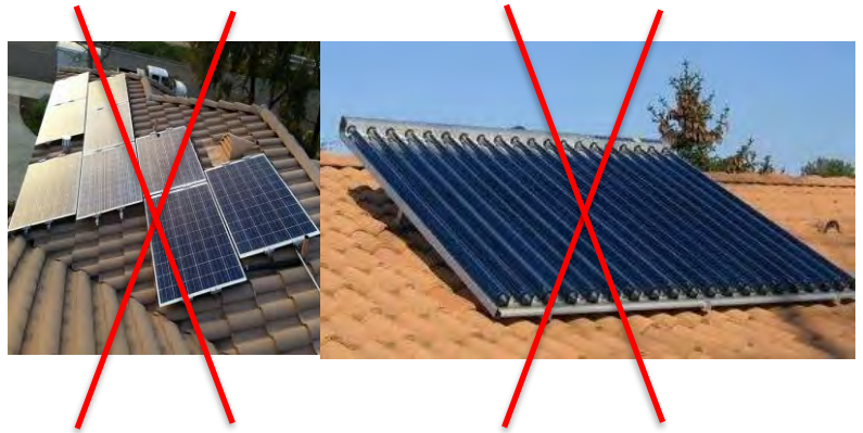
Implantations interdites : implantations anarchiques et/ou en surinclinaison
