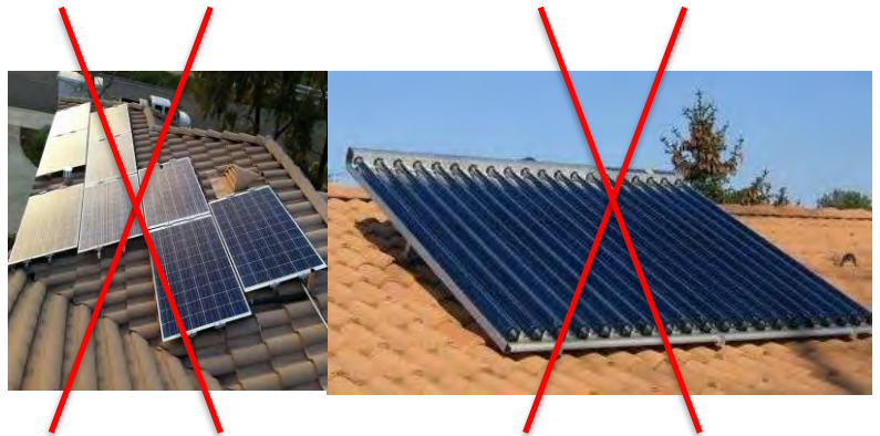
Implantations interdites : implantations anarchiques et/ou en surinclinaison
