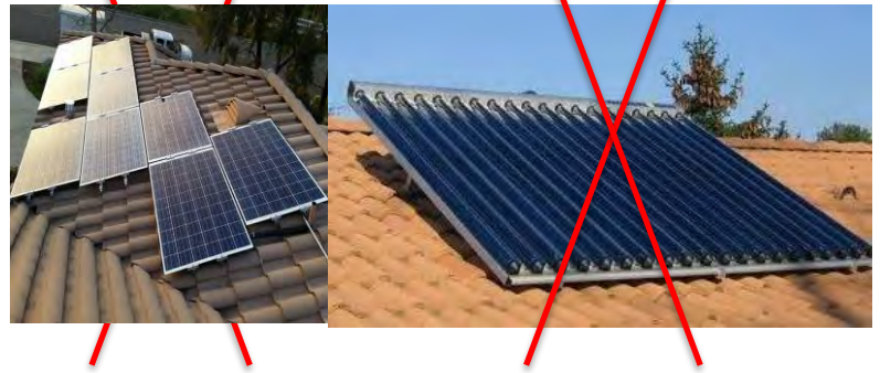
Implantations interdites : implantations anarchiques et/ou en surinclinaison
