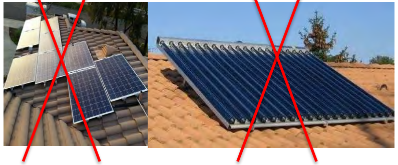
Implantations interdites : implantations anarchiques et/ou en surinclinaison
